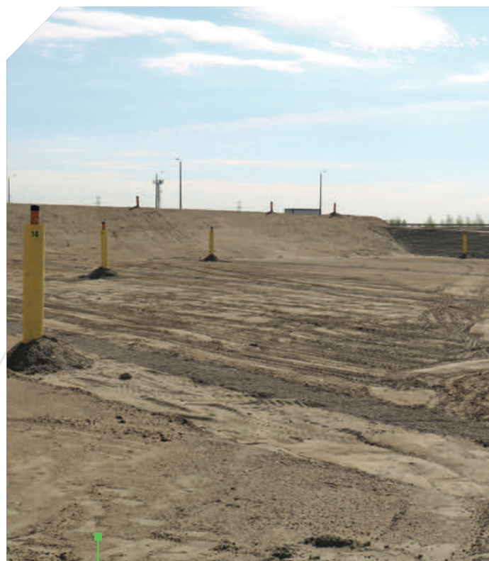
KWATERA SKŁADOWANIA ODPADÓW BALASTOWYCH, STUDNIE BIOGAZOWE
