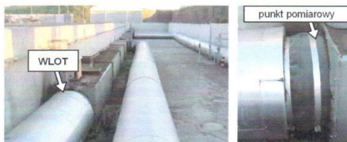
Rysunek 3. Lokalizacja punktu pomiarowego na wlocie do biofiltra
