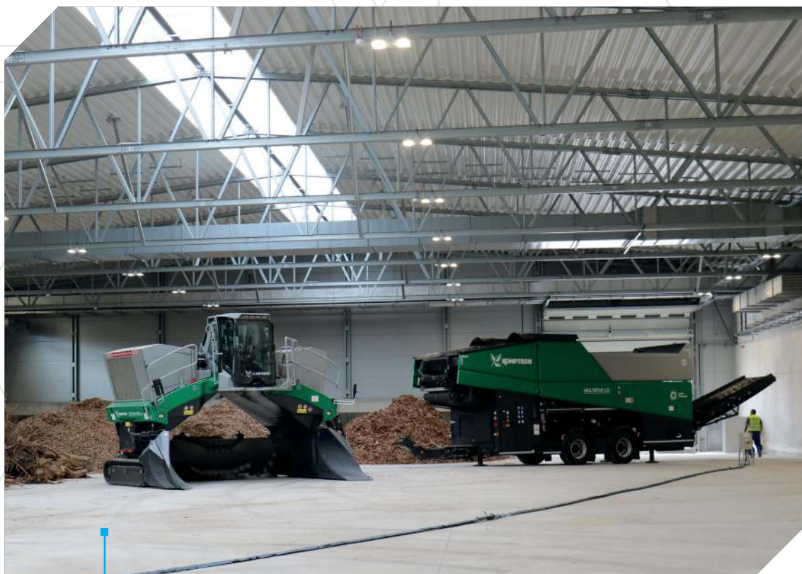
HERMETYCZNA KOMPOSTOWNIA, HALA DOJRZEWANIA
