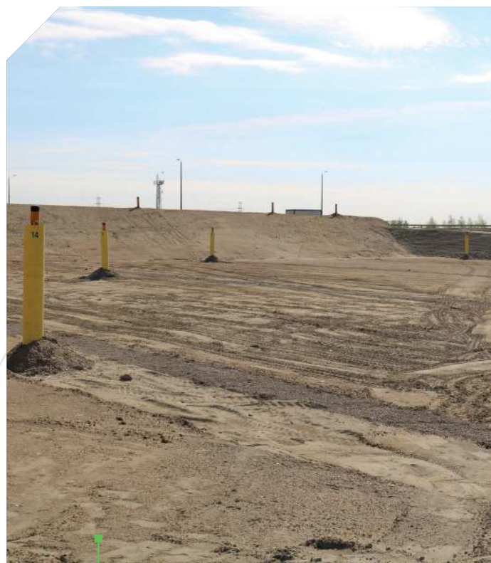
KWATERA SKŁADOWANIA ODPADÓW BALASTOWYCH, STUDNIE BIOGAZOWE
